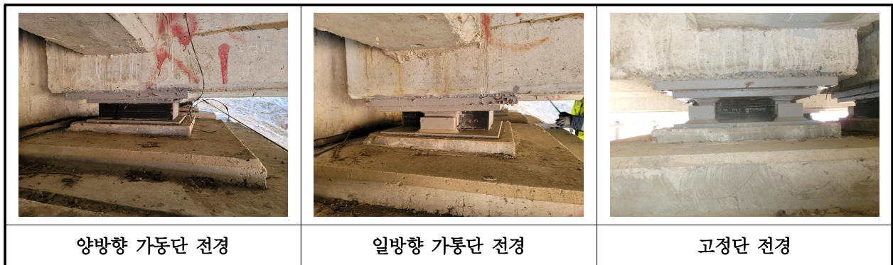
【사진 3.16】 교량받침 전경
