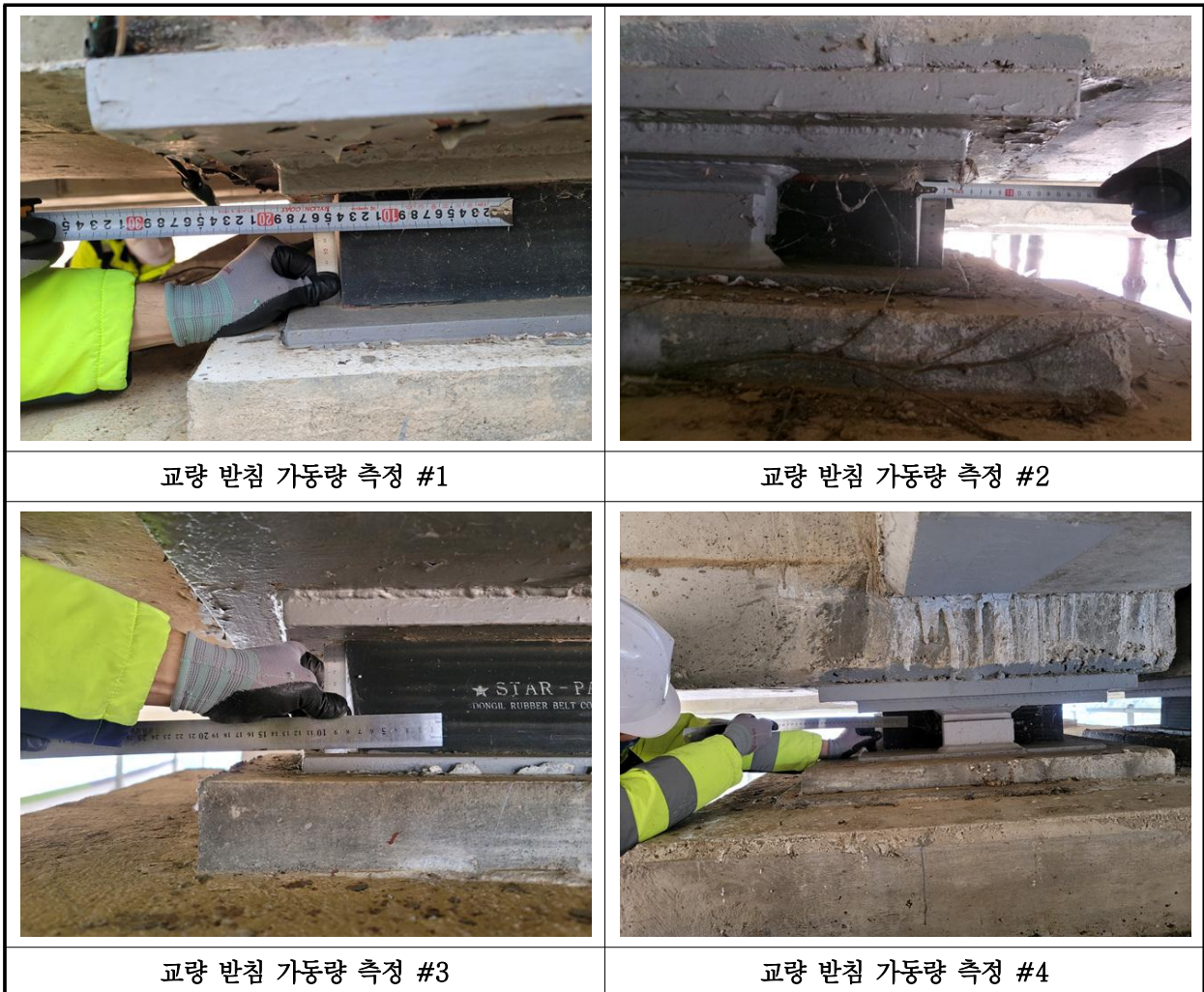
【사진 3.19】 교량받침 이동량 측정
