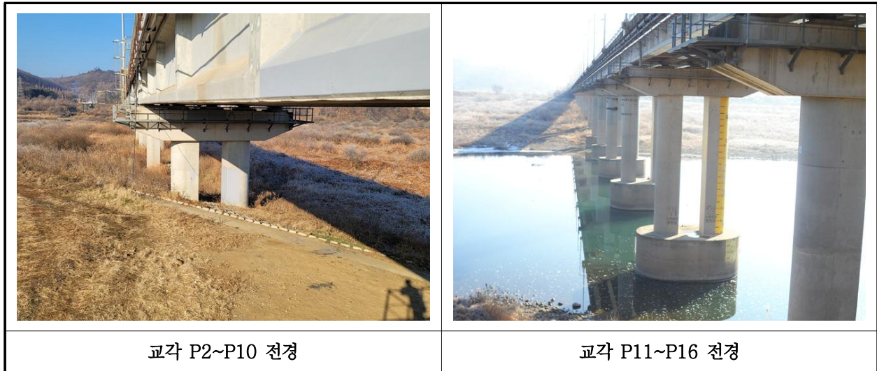
【사진 3.12】 교각 전경
