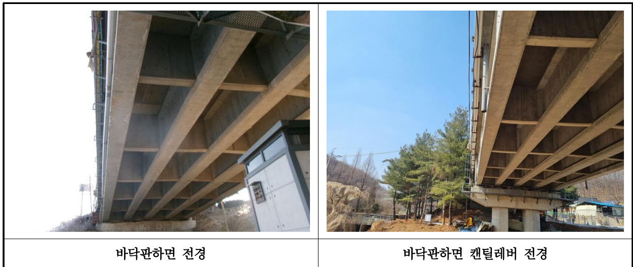
【사진 3.4】 바닥판하면 전경
