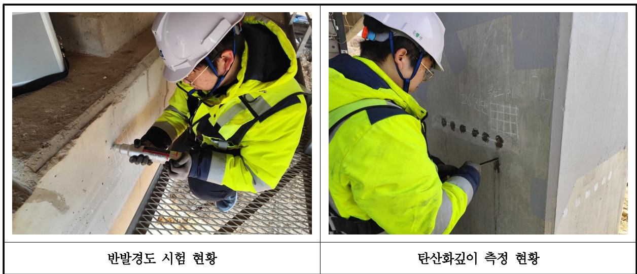
【사진 3.34】 콘크리트 내구성조사 현황
