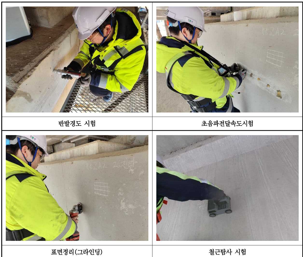
【사진 3.35】 콘크리트강도 시험 현장사진
