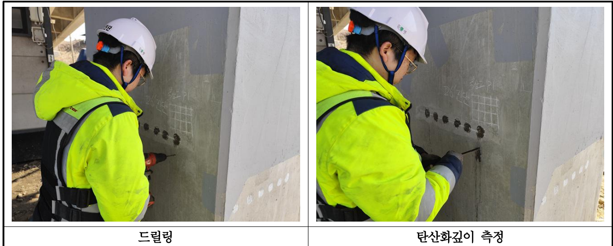
【사진 3.37】 탄산화 깊이 측정 현장사진
