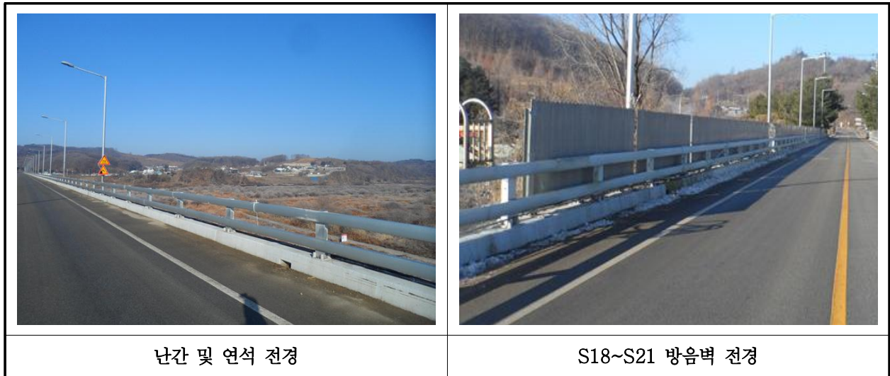
【사진 3.27】 난간 및 연석 전경
