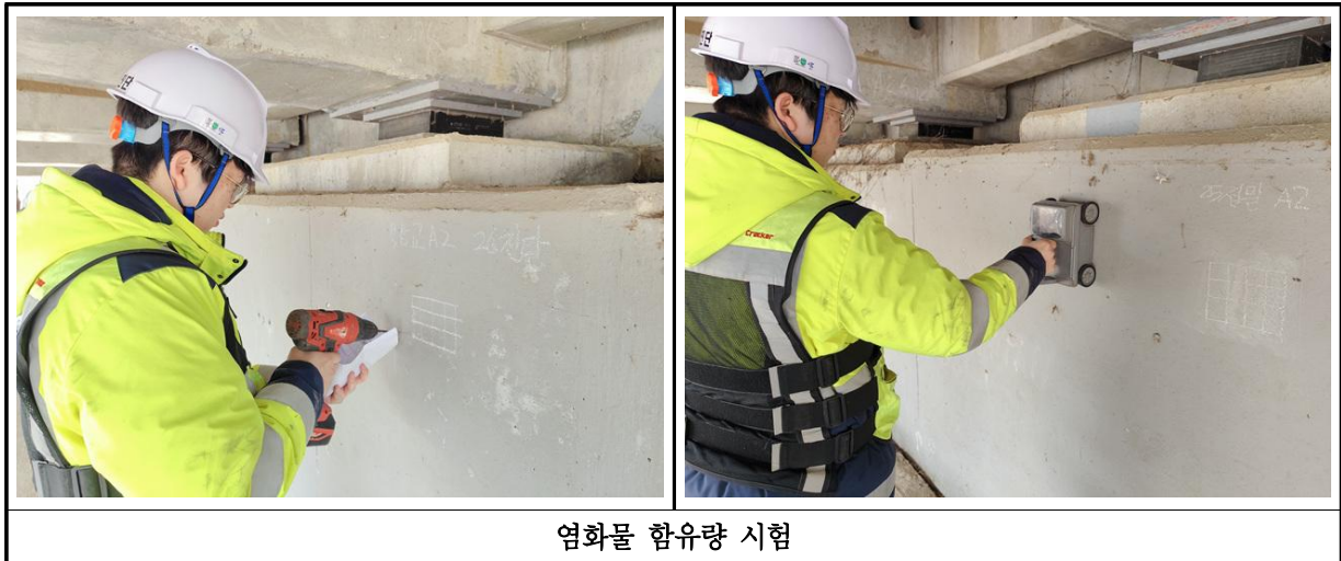
【사진 3.38】 염화물 함유량 시험 현장사진
