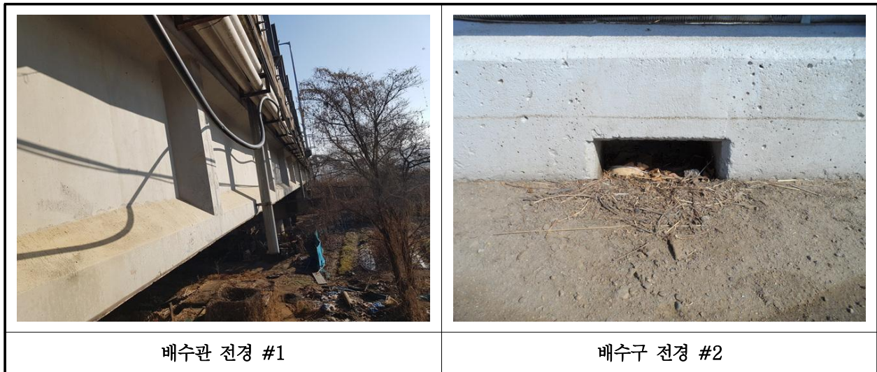
【사진 3.25】 배수시설 전경
