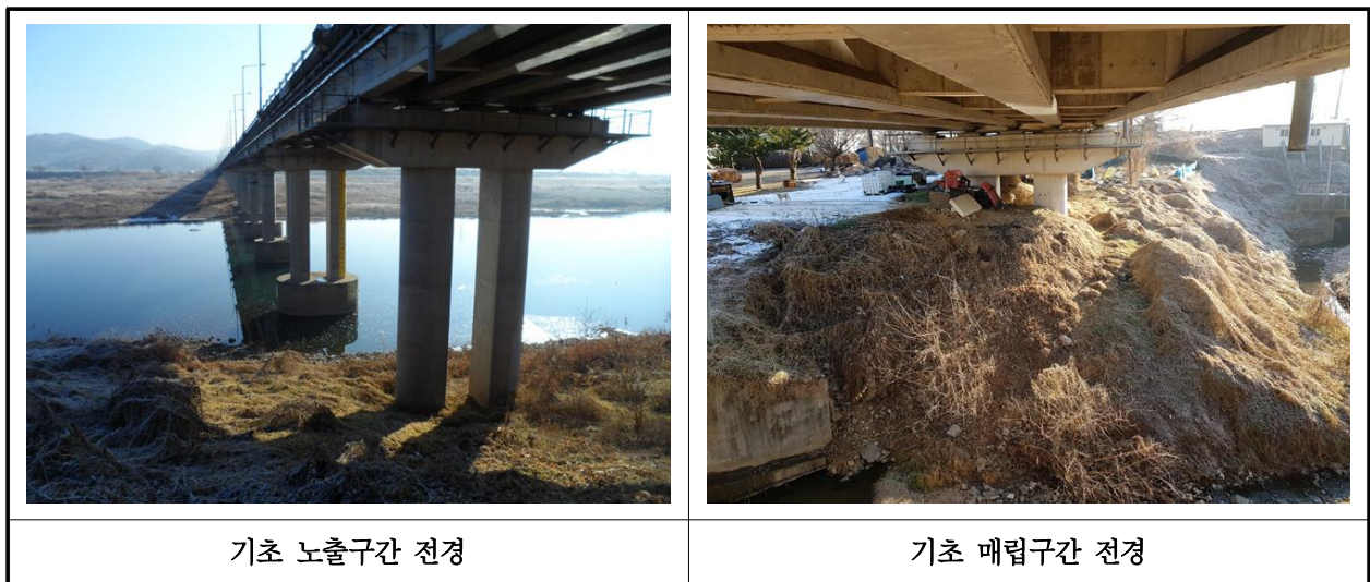
【사진 3.14】 기초 전경
