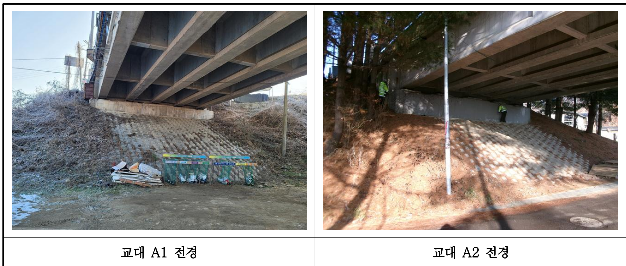
【사진 3.10】 교대 전경
