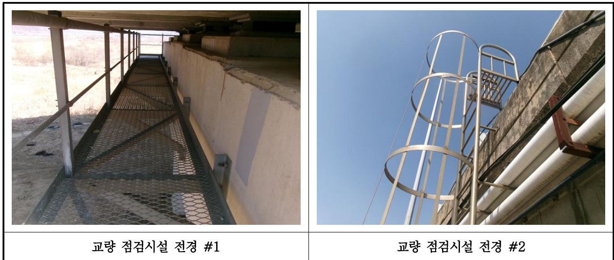
【사진 3.29】 교량 점검시설 전경
